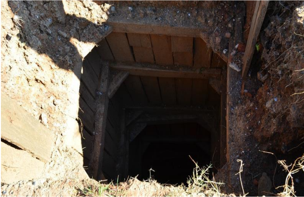
Photo 10: Soutènement d'un puits par des planches vu dans un site d'exploitation mécanisé de Tsarafara
